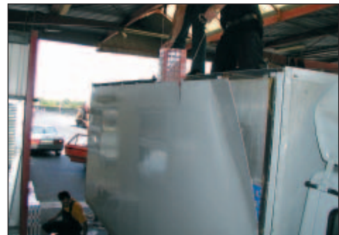
Bus IVECO DAILY z dodatkowymi ścianami bocznymi, podwójną podłogą i przerobionym dachem.
